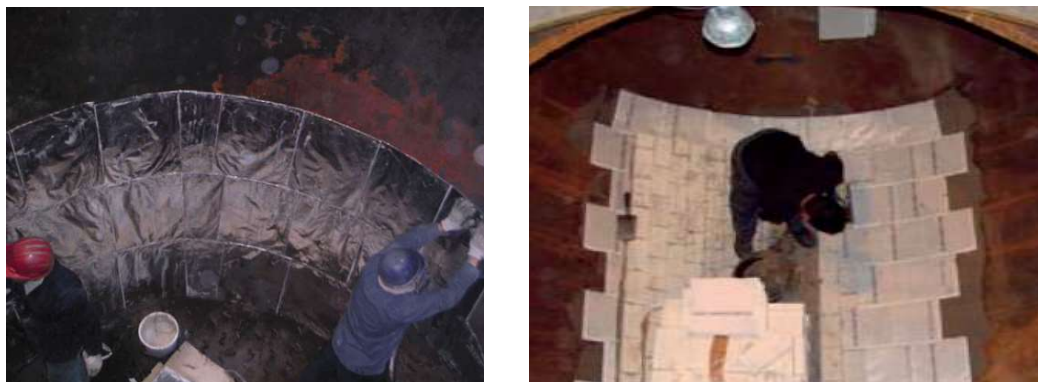
图3 的在钢包上的安装施工
