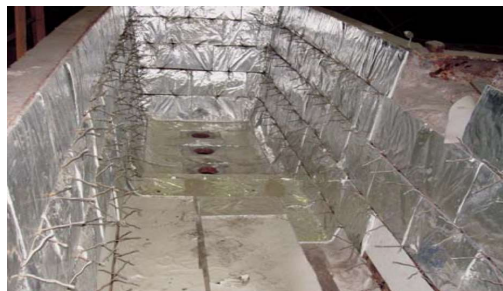
图5 的在中间包上的安装施工
